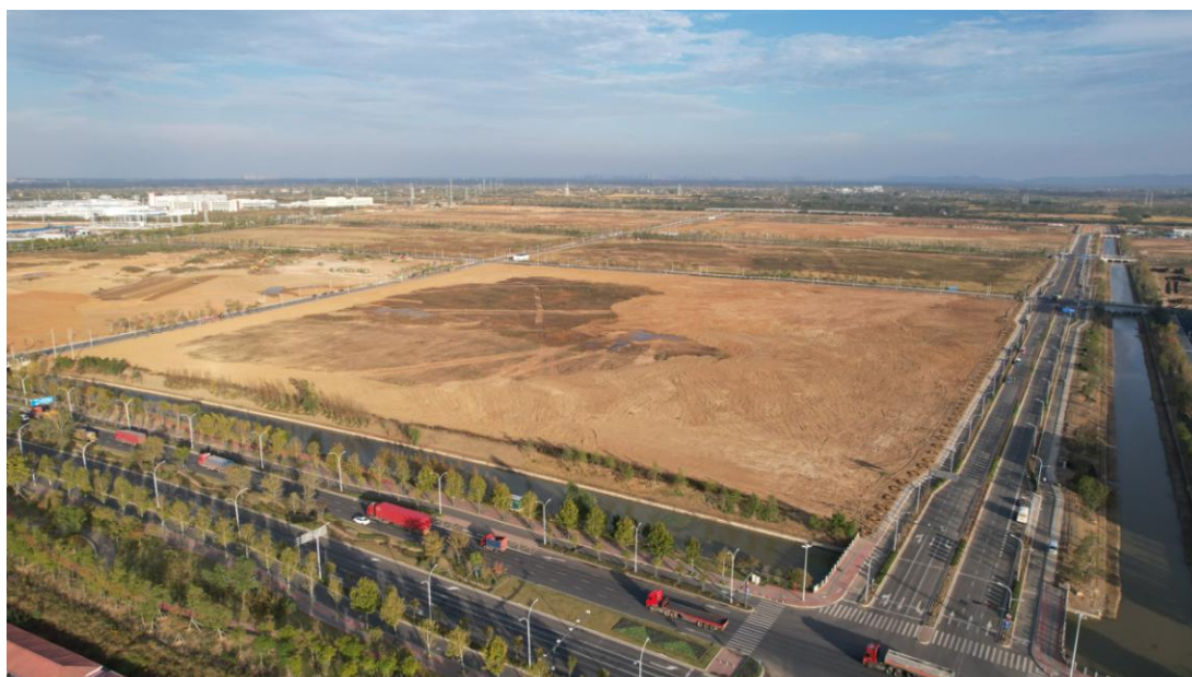
正在进行表土剥离的 F 地块
