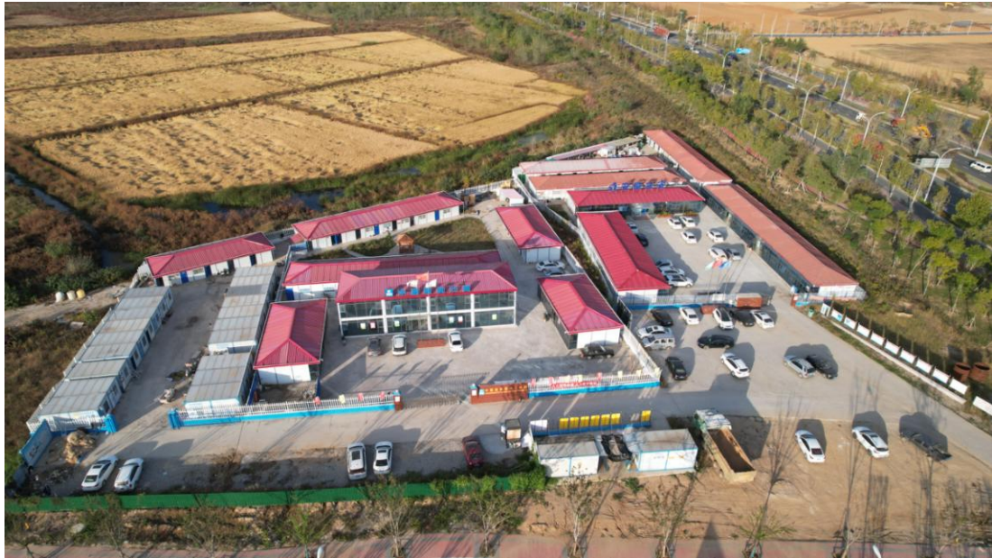
公建项目施工营地
