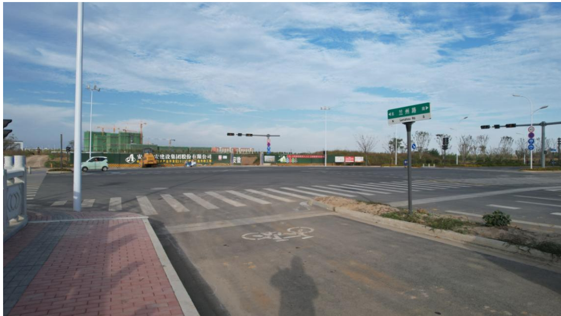
施工围界临时拦挡措施
