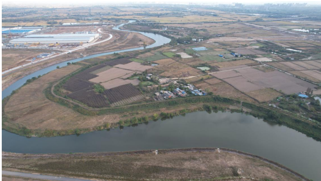
N 地块沧浪街建设中
