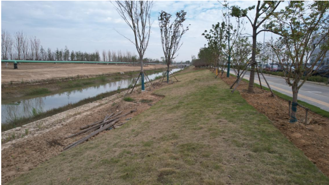
在建区植被建设中（M 地块湖州路河道堤防）
