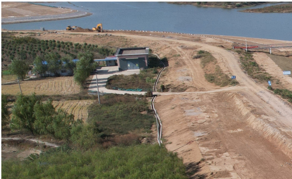
河道堤防坡脚排水沟
