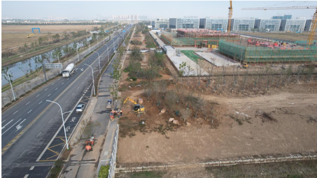
在建区植被建设中（清流河下游 M 地块子美路）
