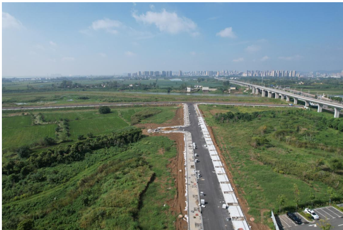
主体工程基本完成的中心五路
