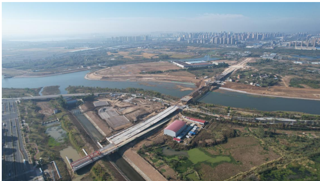
建设中的九梓大道跨清清河大桥
