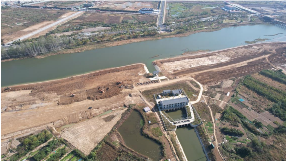
建设中的清流河水系整治工程项目
