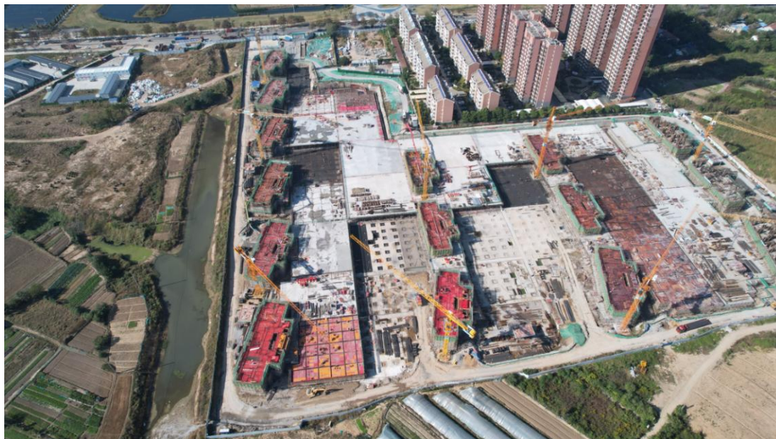
建设中的 G 地块房地产项目
