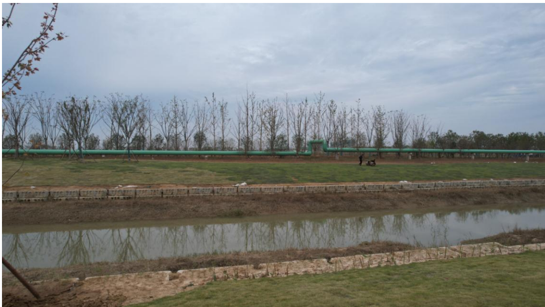
在建区草皮铺植建设中（M 地块湖州路河道堤防）
