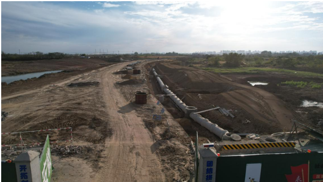
路侧布设排水管道
