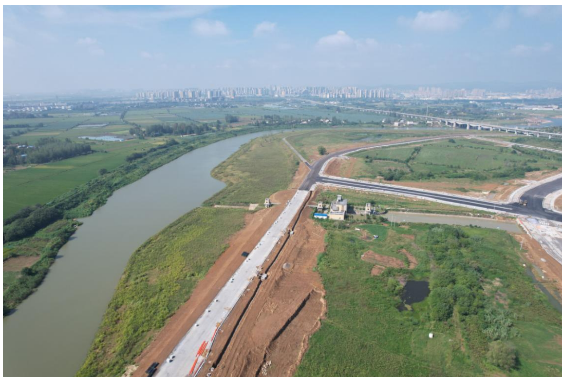
建设中的滨江北路
