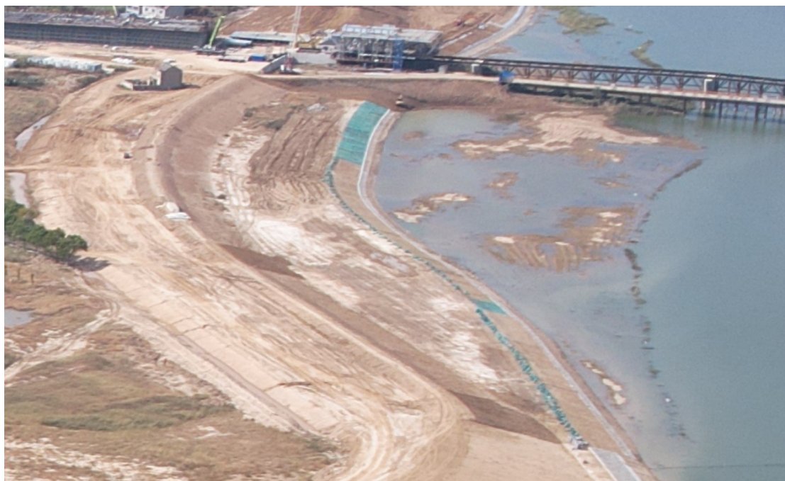
河道施工边坡临时苫盖
