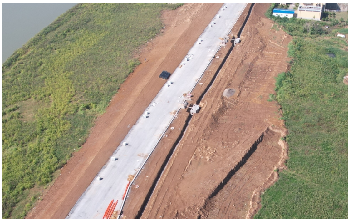
建设中的滨江北路排水沟
