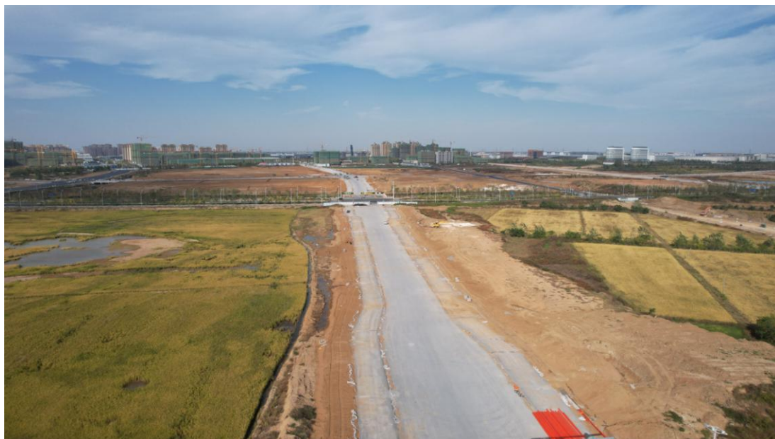
正在建设中的中心三路
