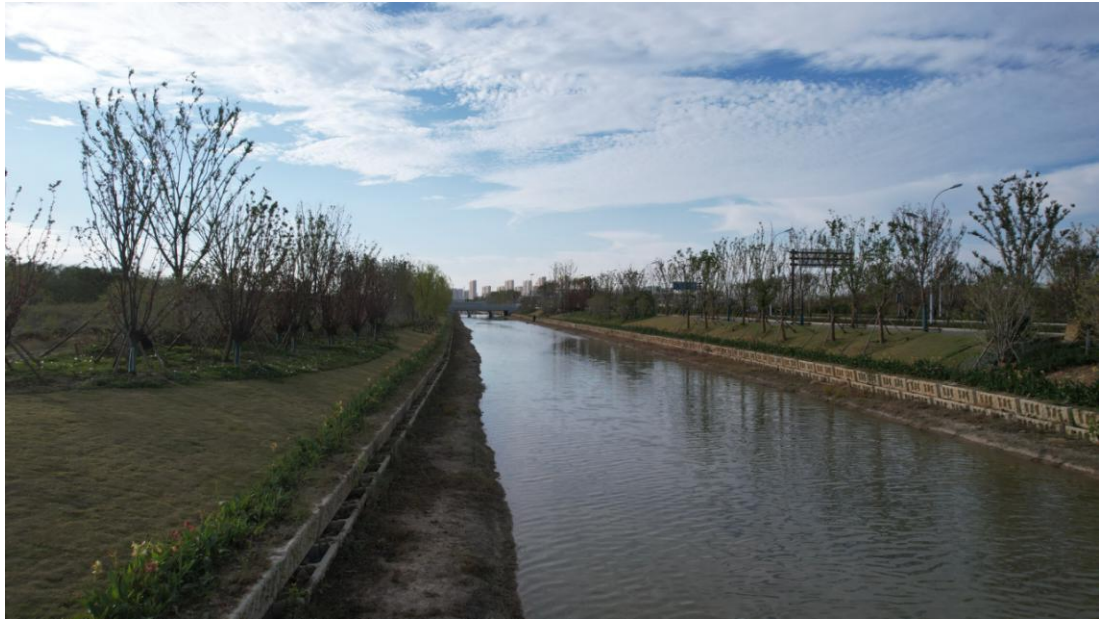
友谊路河道生态框格边坡防护
