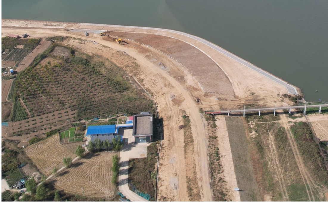
河道边坡防护
