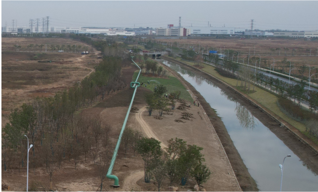
在建区草皮铺植建设中（M 地块湖州路河道堤防）
